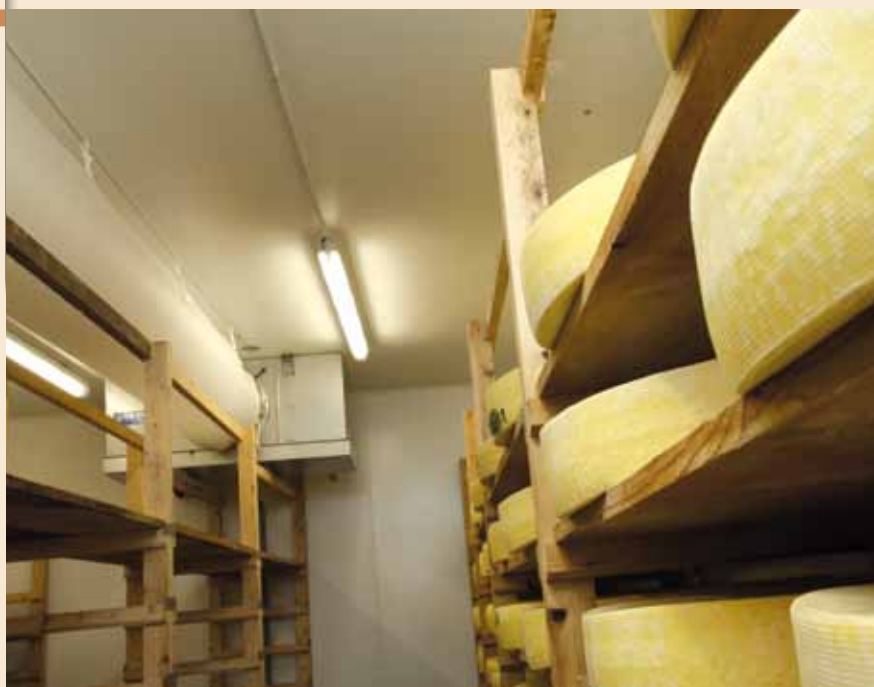
79% des ateliers diagnostiqués ont réalisé les travaux préconisés, au moins en partie, ou ont le projet d'en réaliser. Ici, l'isolation des caves et l'installation d'un groupe de régulation à La Marre.
