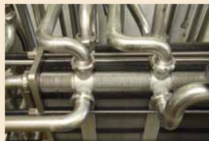
Le récupérateur de chaleur existant a été équipé d'un échangeur à plaques plus performant.
