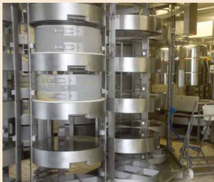
Le diagnostic énergie-fluides étudie aussi les rejets de l'atelier de la fromagerie.
