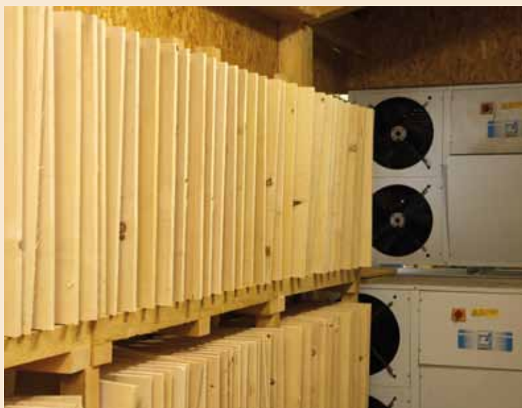
Le séchage des planches d'affinage se fait par la chaleur des moteurs des groupes "froids".
