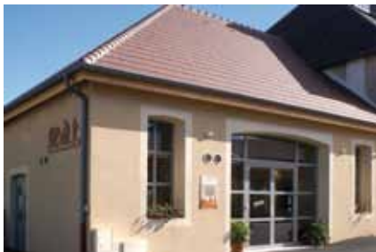
Les travaux ont porté sur la mise aux normes de l'atelier de fabrication (700 000 euros) et la construction d'un magasin de vente (400 000 euros).
